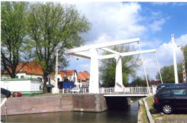
Afb. 14: De huidige Kaaibrug. Foto H. Vegter.
