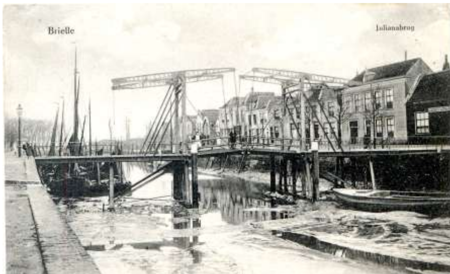
Afb. 8: Julianabrug uit 1909 bij laag water. Fotocollectie H. Vegter.
