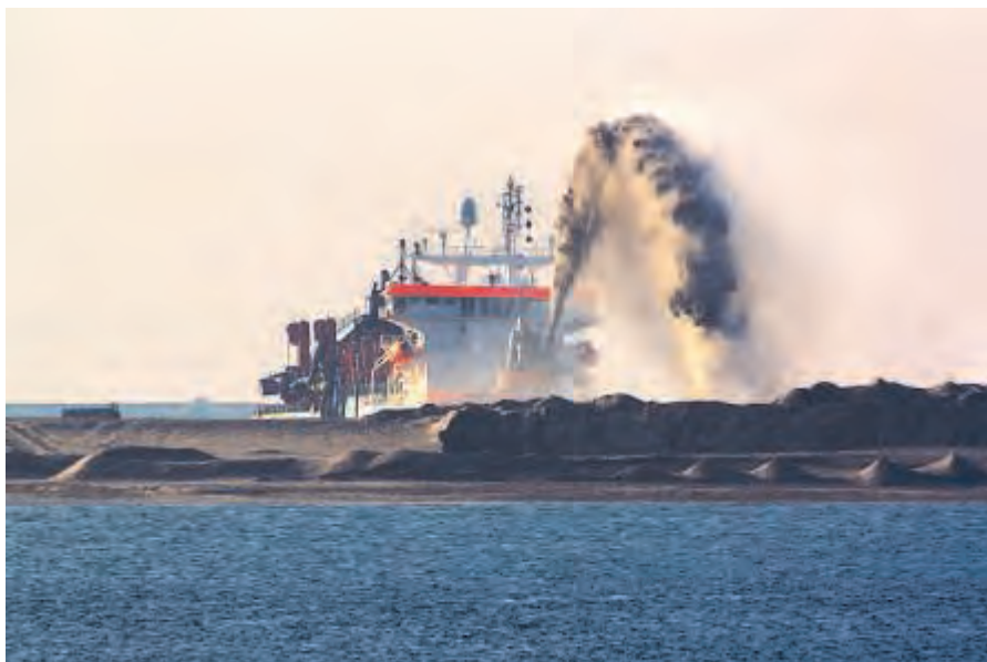
Aanleg van Maasvlakte 2 . Foto Hans Wildschut.
