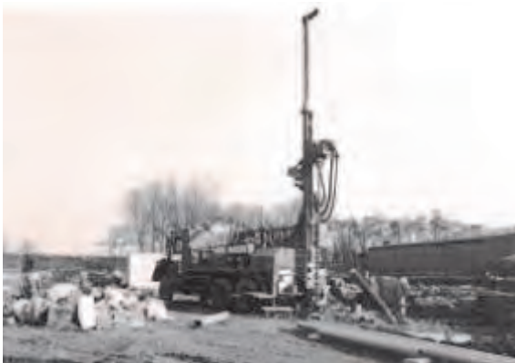
Afb. 14: Bodemsanering op het terrein van de vroegere gasfabriek. Foto R.G. Meyer, Collectie SVPR.
