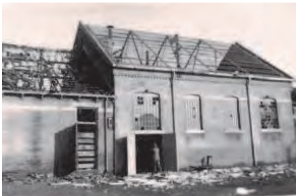
Afb. 11: Schade aan de gebouwen als gevolg van de explosie. Foto J. Dedert.
