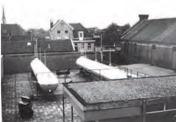
Afb. 13: Propaantanks van de propaan-luchtgasinstallatie. Foto Shell, Collectie SVPR.
