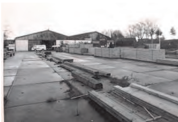
Afb. 15: Opslagterrein van de Houthandel PontMeyer, v/h Houtcentrale De Eilanden, november 1998.
