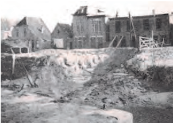
Afb. 20: Schade aan het talud van het Slagveld als gevolg van een bom. Op de kade lag een hoge berg zand tussen de huizen en de plaats van de inslag. Waarschijnlijk bleef daarvoor de schade aan de huizen beperkt. Foto J. Dedert.
