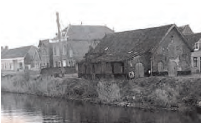
Afb. 18: Het 'baanhuis' bij het begin van de sloop, 8 juni 1962.
