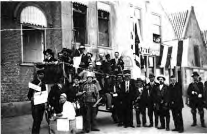
Mede dankzij deze foto uit omstreeks 1920 was het mogelijk de oorspronkelijke lagenmaat (steendikte plus voegdikte) te bepalen. Foto SVPR.
